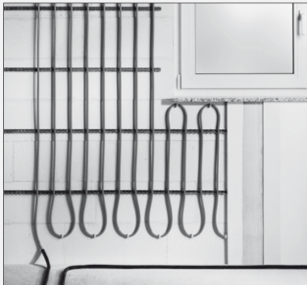
Система стенового панельного отопления для полибутиленовых труб для влажного способа отделки.
