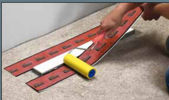
Шаг 3 – Наклеивание гидроизоляционной манжеты Seal System
