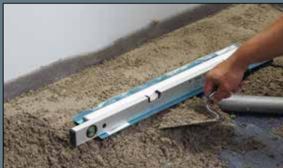
Шаг 2 – Укладка бетонной стяжки
