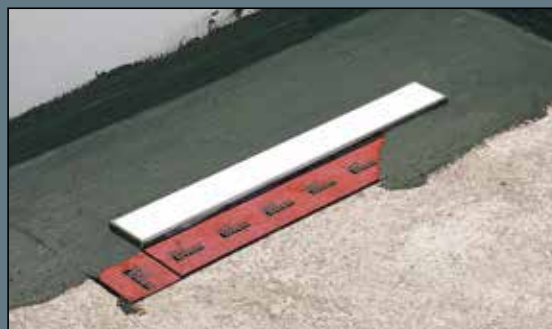
Шаг 4 – Нанесение гидроизоляционного слоя
